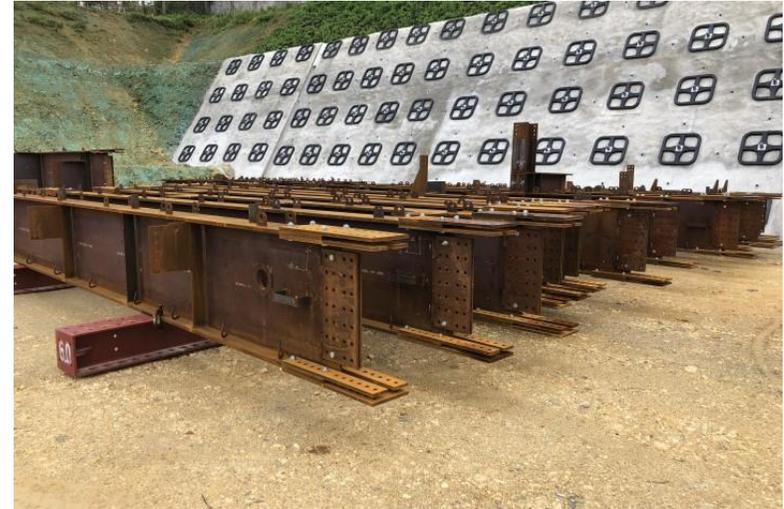
写真⑫(鉄骨工事 2階 鉄骨梁搬入状況)
