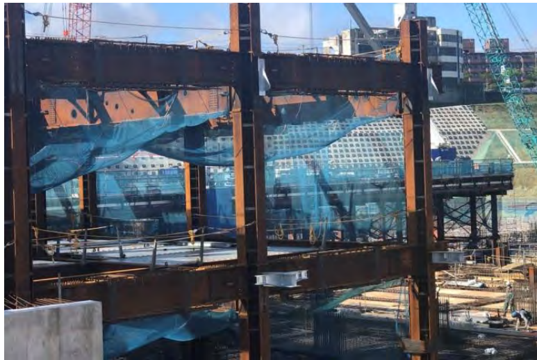
写真⑪ (鉄骨工事 1階 鉄骨建て方施工状況)
