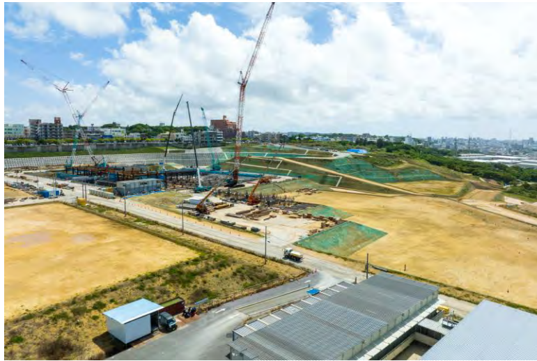
写真⑨(北東側)
