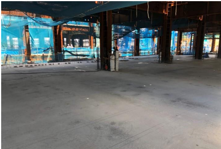
写真⑪ (コンクリート工事 2階 コンクリート施工状況)
