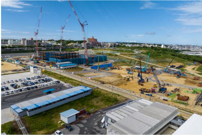
写真⑨(北東側)
