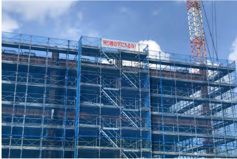
写真⑬ (東側 外部足場組立状況)
