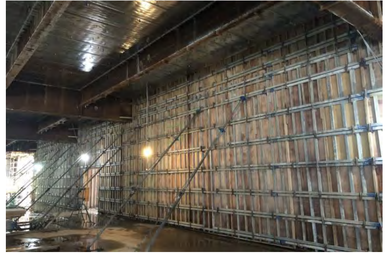
写真⑭ (1階 型枠組立状況)
