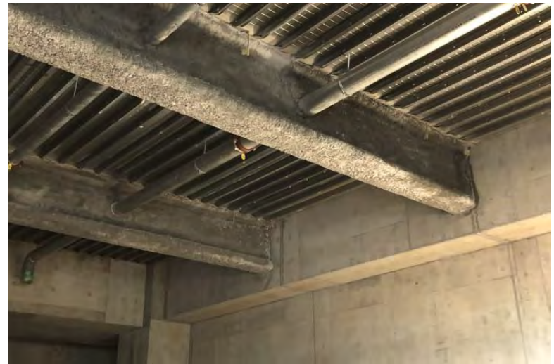
写真⑫ (鉄骨工事 1階 耐火被覆吹付施工状況)
