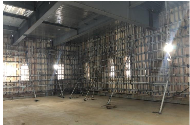
写真⑫ (型枠工事 3階 壁型枠施工状況)
