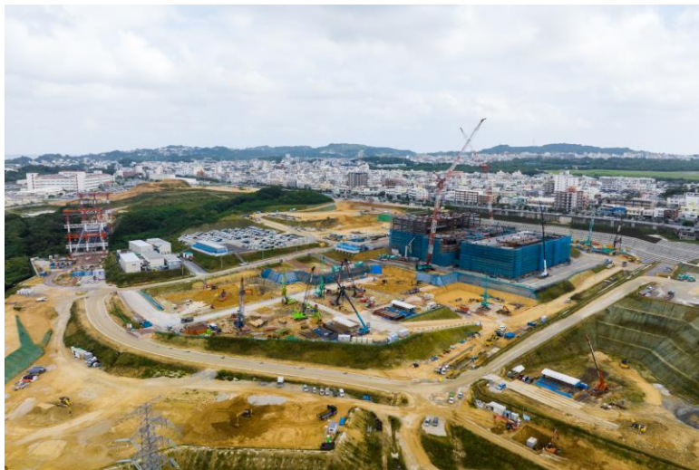
写真⑦(北西側)
