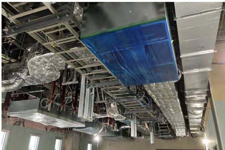
写真⑬ (機械工事 5階集中治療室 機器・ダクト吊込状況)
