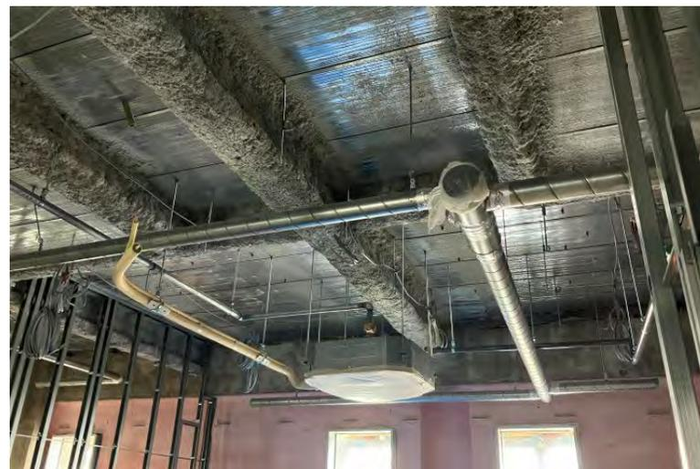
写真⑭ (機械工事 8階病室 先行吊込状況)
