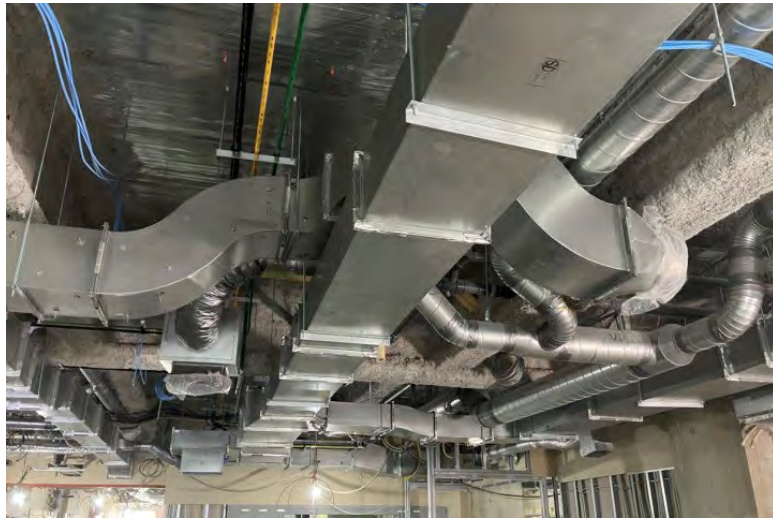
写真⑬ (機械工事 8階スタッフステーション 天井内吊込状況)
