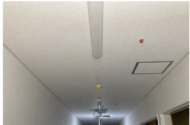
写真⑭ (電気工事 4階廊下 器具取付状況)
