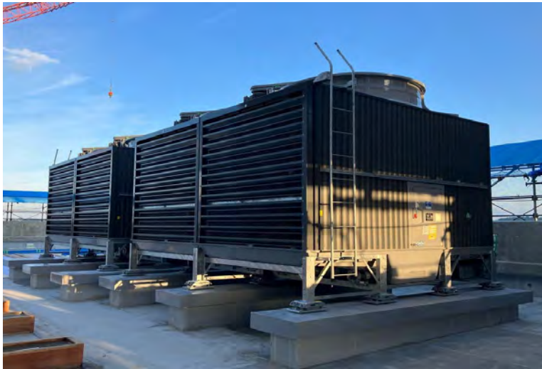
写真⑬ (機械工事 14階屋上 冷却塔設置状況)
