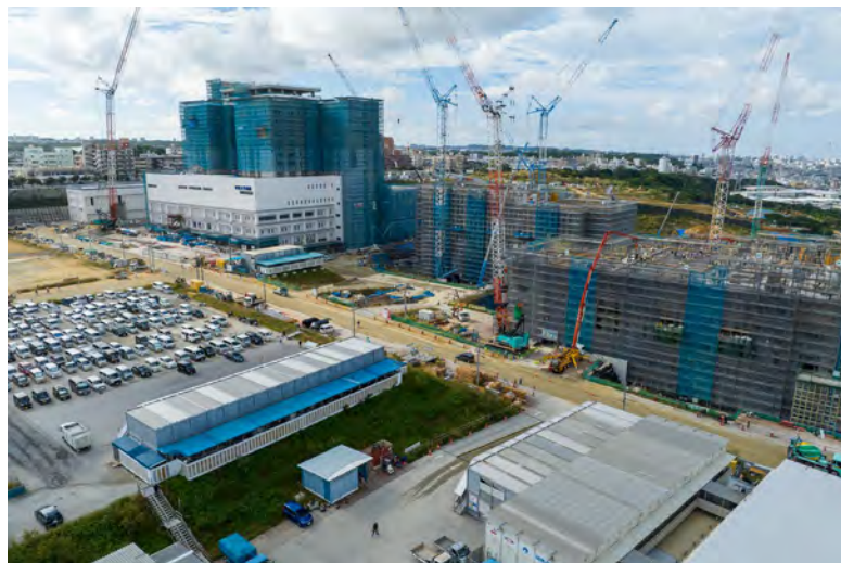
写真⑨(北東側)
