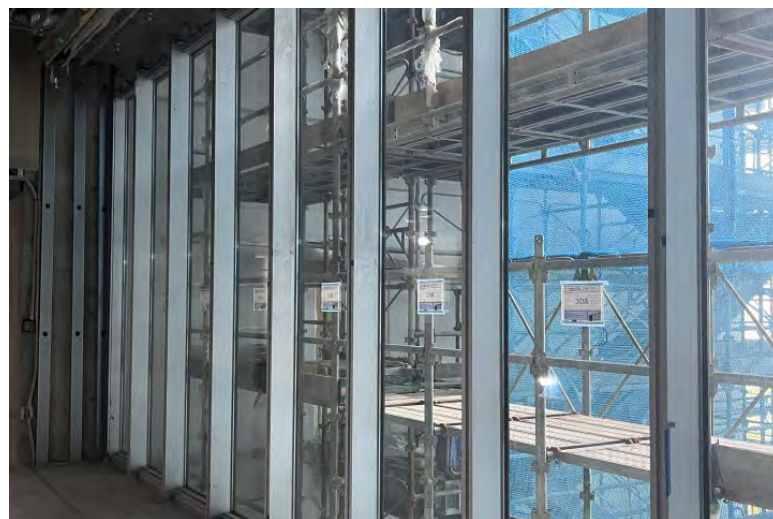
写真⑫ (建具工事 カーテンウォール施工状況)
