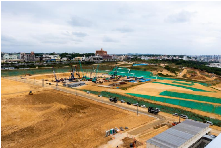
写真⑨(北東側)
