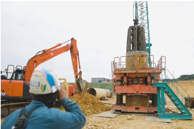
写真⑪(杭工事 掘削の様子)
