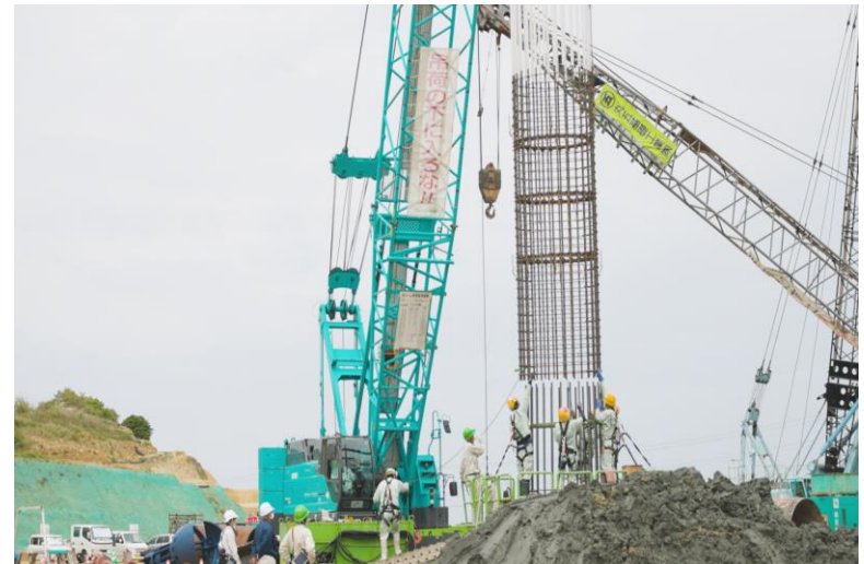
写真⑫ (杭工事 鉄筋籠建て込みの様子)
