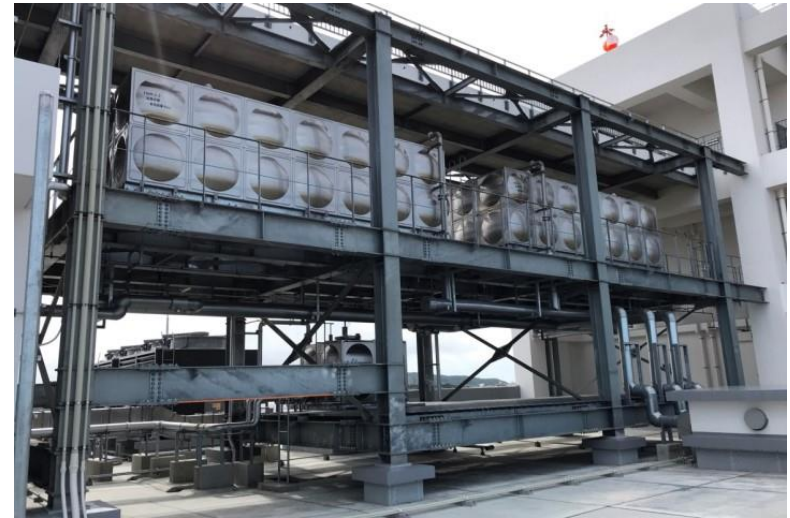
写真⑭ (機械設備 14階 屋上 高架水槽施工状況)
