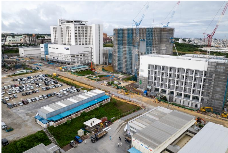
写真⑨(北東側)
