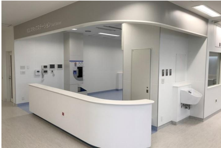
写真⑬ (機械設備 5階 ICU スタッフステーション施工状況)
