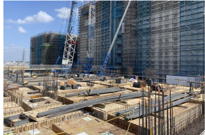
写真⑭ ( D棟 鉄筋工事 2階 梁配筋状況 )
