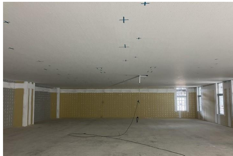
写真⑫ ( B棟 内装工事 2階 天井ボード施工状況 )
