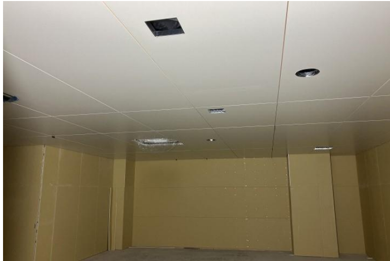
写真⑬ ( C棟 内装工事 2階 天井施工状況 )
