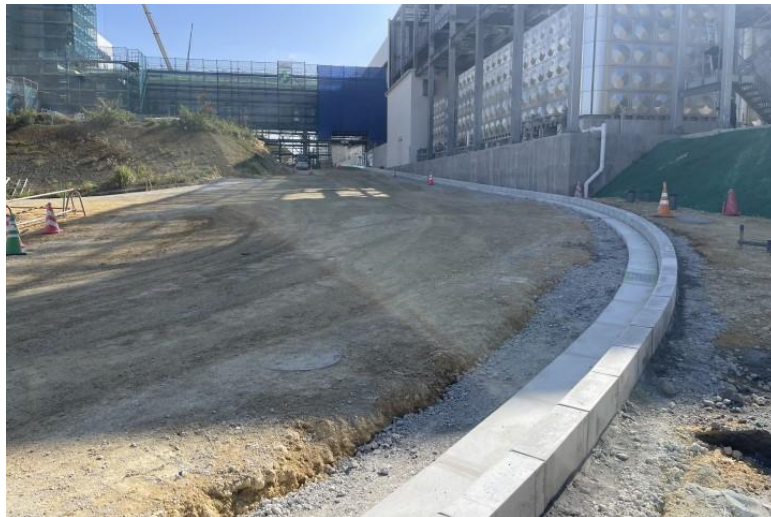
写真⑮ ( キャンパスアベニュー 歩車道ブロック設置状況 )
