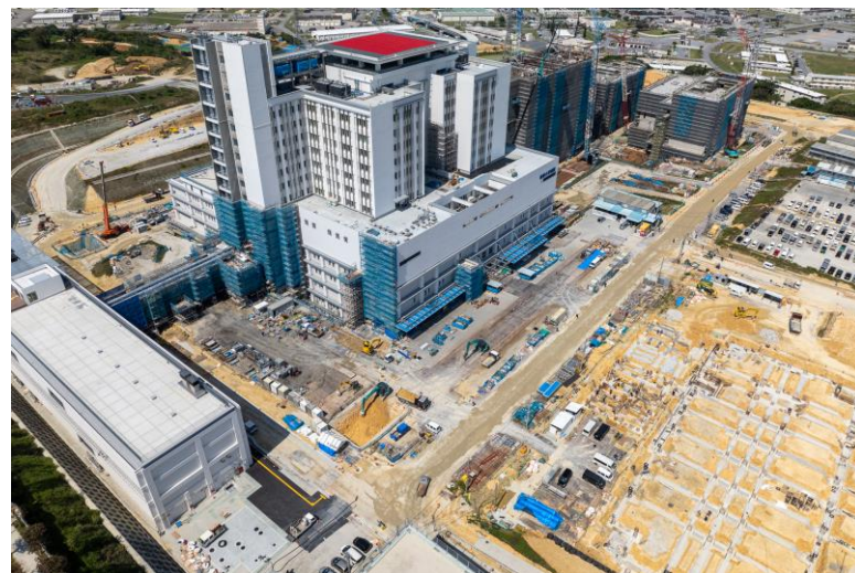
写真②(南南東側)
