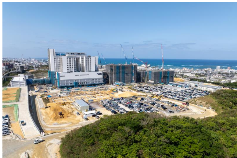
写真①(東南東側)
