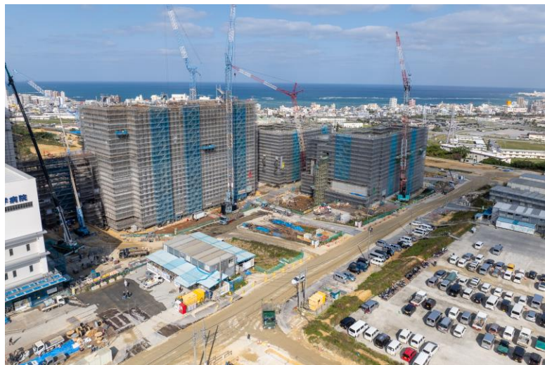
写真⑨(南東側)
