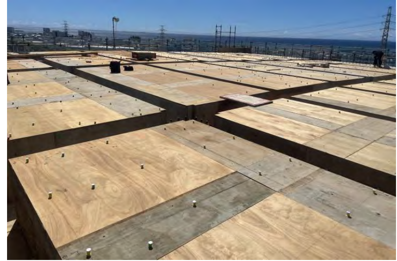
写真⑭ ( D棟 型枠工事 R階 床施工状況 )
