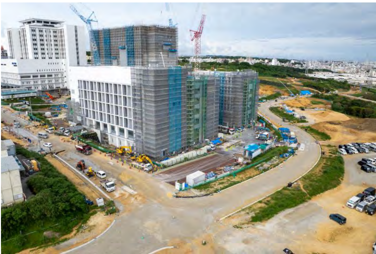
写真⑦(北北東側)
