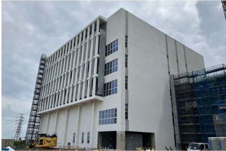
写真⑬ ( C棟 仮設工事 南西外部 足場解体状況 )
