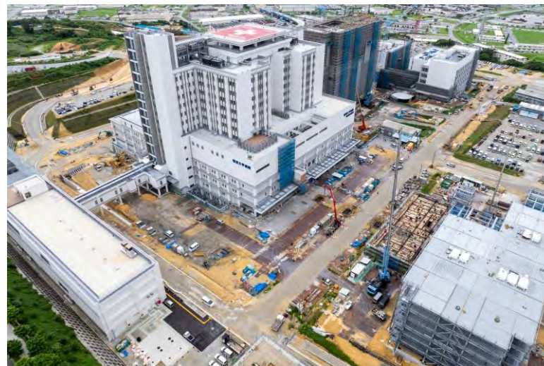
写真②(南南東側)
