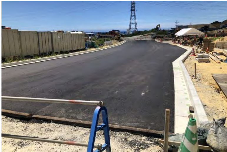
写真⑮ ( キャンパスアベニュー アスファルト舗装基層状況 )
