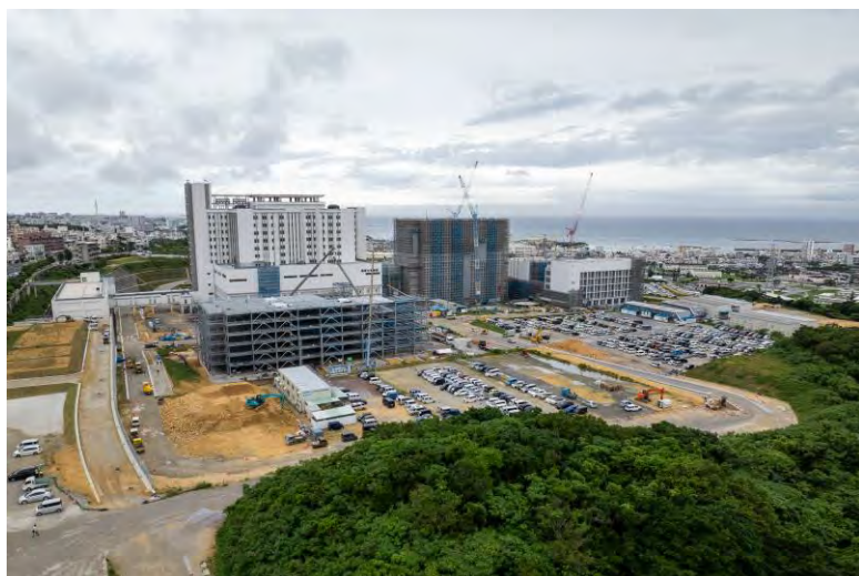
写真①(東南東側)
