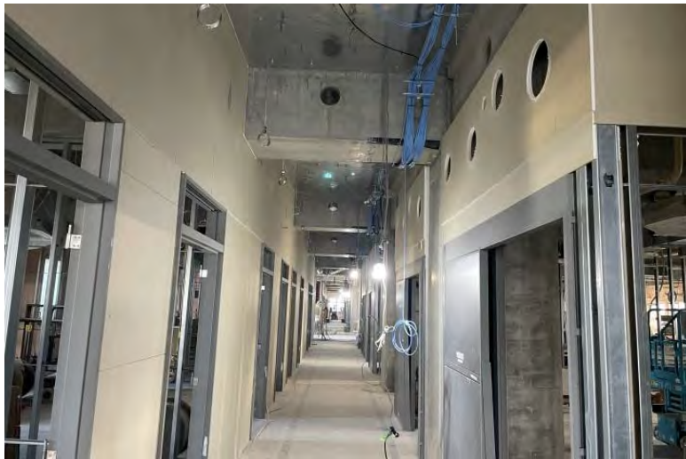
写真⑪ ( A棟 内装工事 11階廊下 ボード貼状況 )
