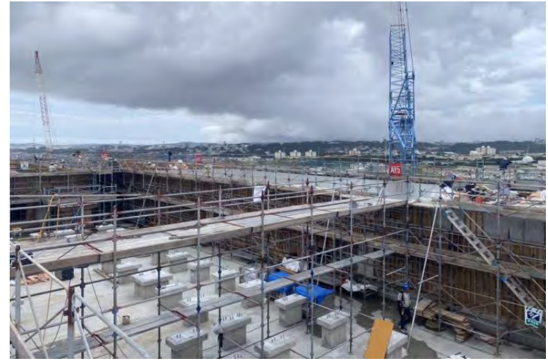
写真⑩ ( A棟 コンクリート工事 13階 立上り状況 )
