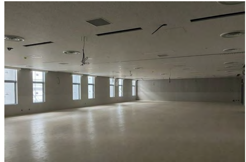
写真⑫ ( B棟 内装工事 5階 内装仕上状況 )
