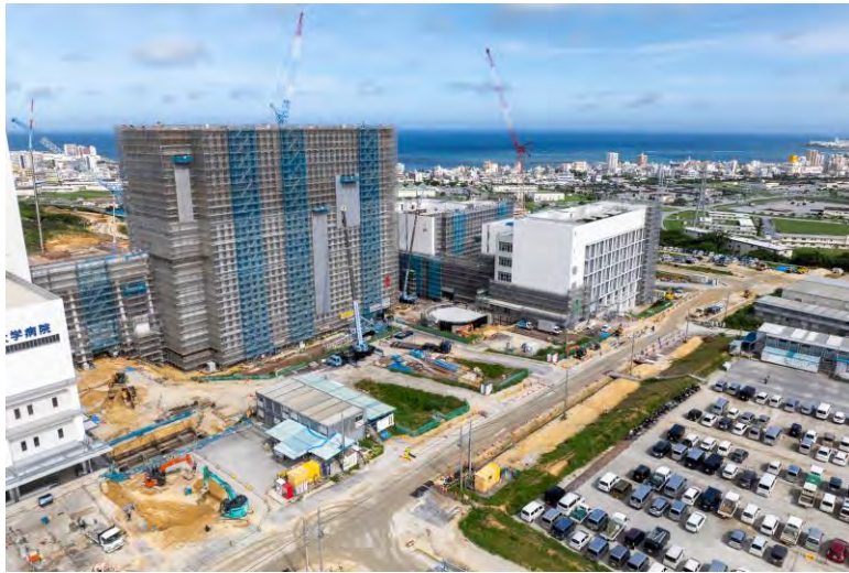
写真⑨(南東側)
