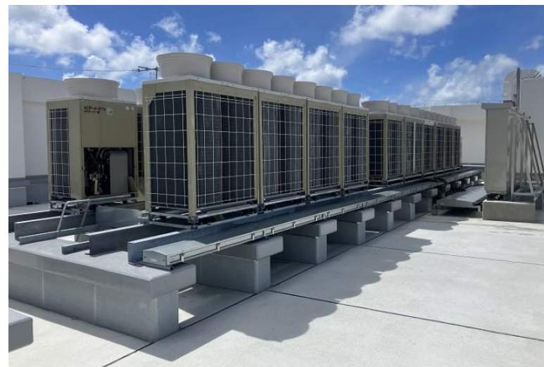
写真⑫ ( C棟屋上 空調設備据付状況 )
