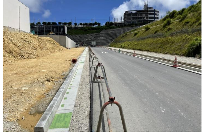
写真⑭ ( キャンパスアベニュー 歩車道 ブロック据付状況 )
