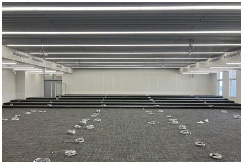
写真⑪ ( B棟6階 講義室 内装仕上げ状況 )
