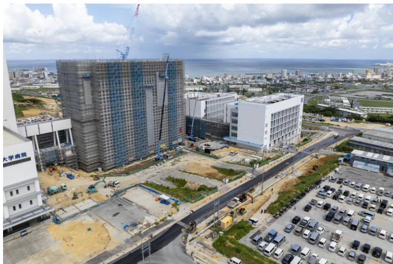
写真⑨(南東側)
