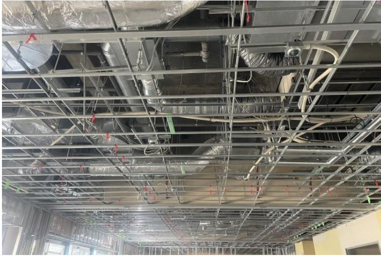
写真⑬ ( D棟1階 金属工事 天井下地状況 )
