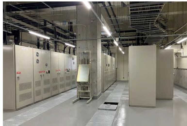
写真⑫ (C棟 内装工事 5階 電気室状況)
