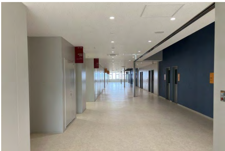
写真⑪ (B棟 内装工事 3階 共用部状況)
