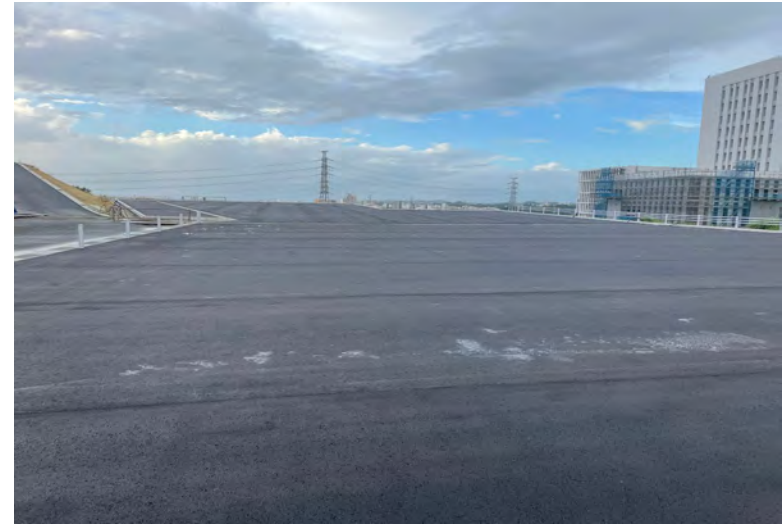
写真⑭ (西 1 駐車場 アスファルト舗装状況)
