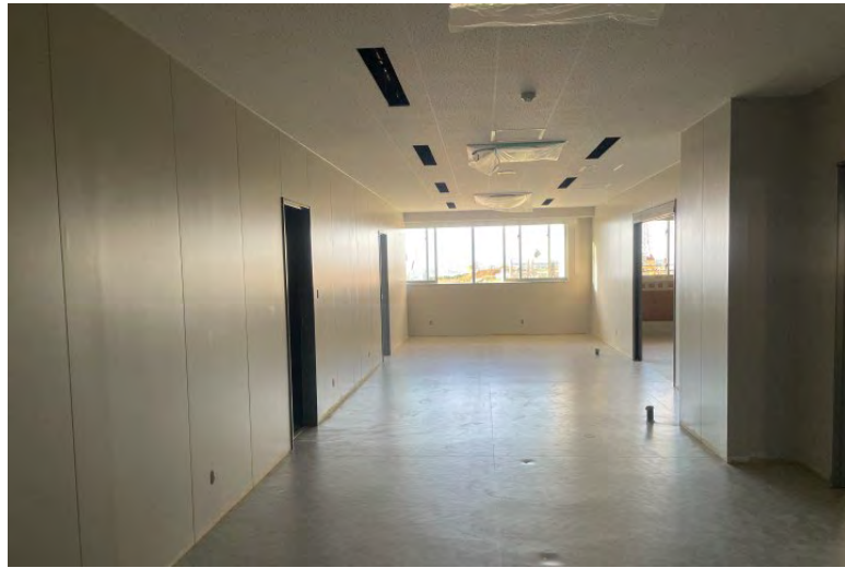
写真⑬ (D棟 内装工事 1階 倉庫仕上状況)
