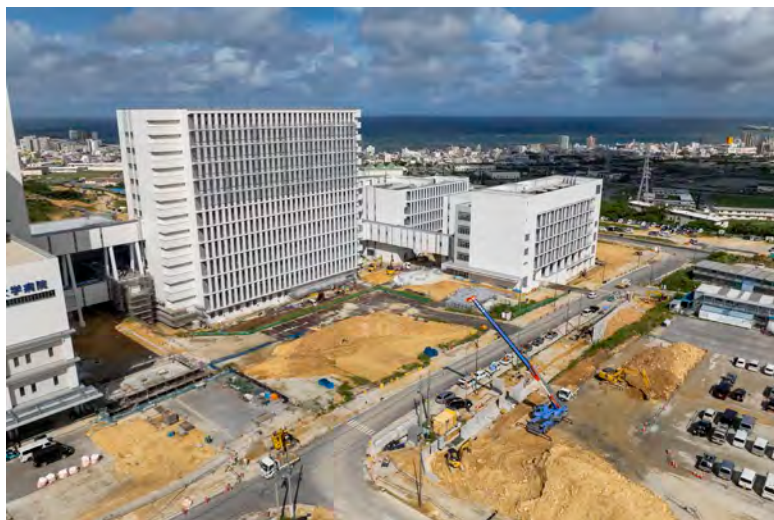
写真⑨(南東側)
