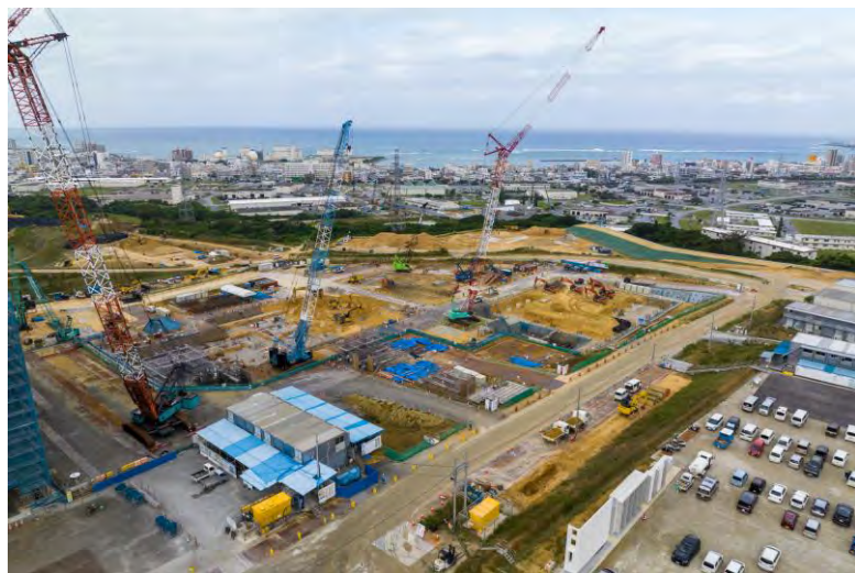
写真⑨(南東側)
