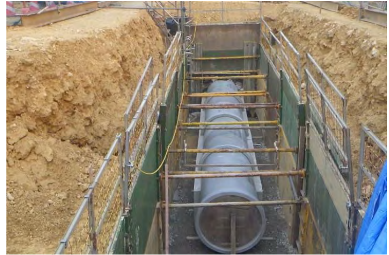
写真⑭ (キャンパスアベニュー 雨水排水工事状況)
