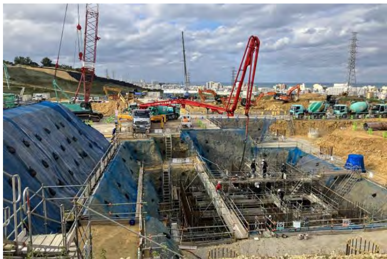
写真⑪ (躯体工事 B棟 基礎コンクリート打設状況)
