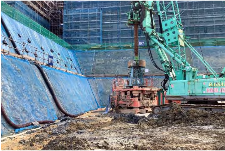
写真⑬ (杭工事 D棟 拡底部掘削状況)
